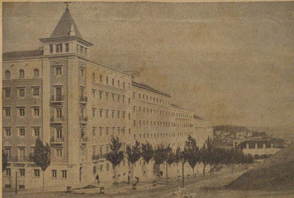
Os nossos operários, sob a orientação dos técnicos, são capazes desta maravilha, que honra e embeleza a Capital do Império e dignifica a Nação. Respeitemos o seu valor! Mas aqueles que constroem, pelo seu trabalho, estas moradias dignas duma grande cidade, merecem que se pense ainda mais, muito mais ainda nas casas onde habitam, muitos deles, sabe Deus em que condições.
